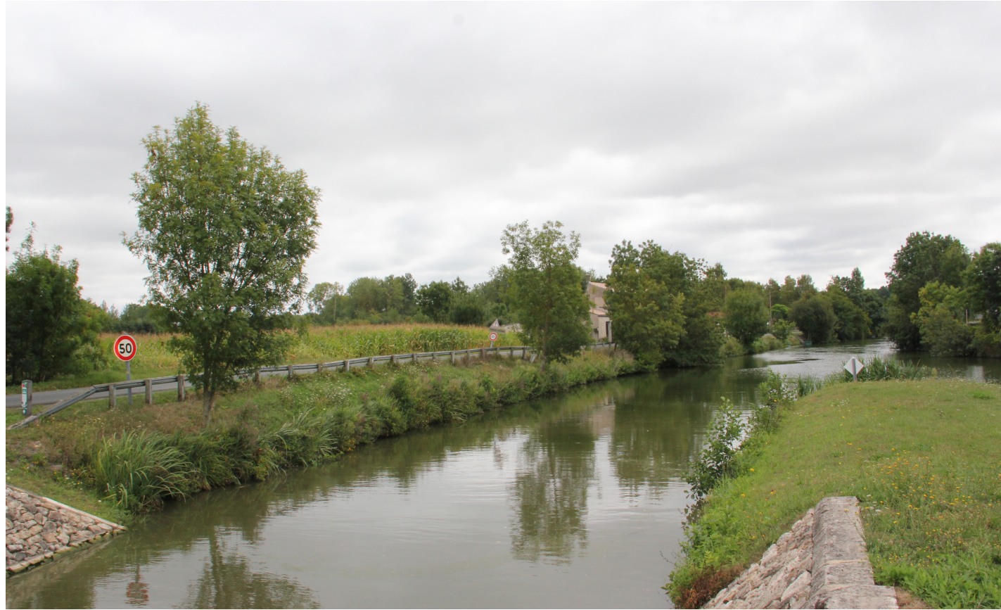
PONTON AMONT : Vue 1 depuis la rive droite de l'îlot de l'écluse (Actuellement)
